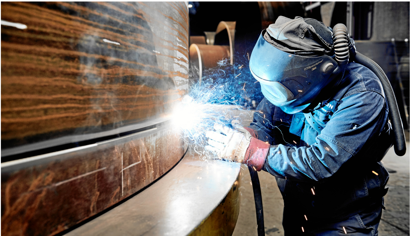
Stålpladetykkelsen er op til 75 millimeter på de største bundsektioner til offshoretårnene.
